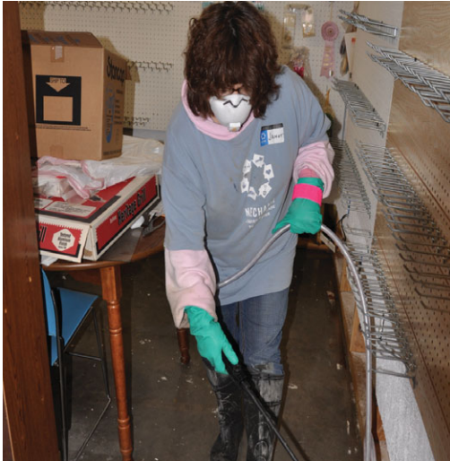
Fotografía de FEMA
